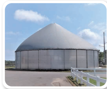
発酵槽 メタンなどのバイオガスを生成するために、嫌気性発酵を行う密閉された槽です。
